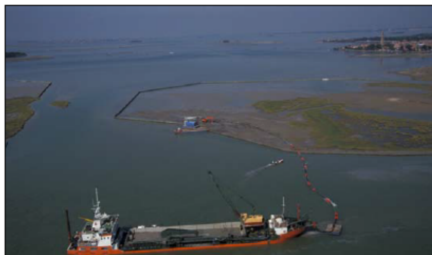
Figura 2-27 Refluimento diretto del sedimento proveniente dalla draga (Barena Palude Burano Sud).
