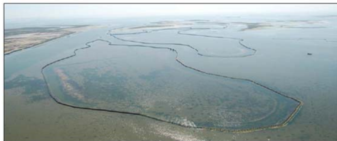
Figura 2-26 Realizzazione della conterminazione.
