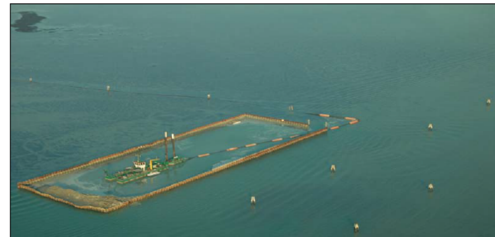
Figura 2-28 Fossa di transito per il deposito temporaneo dei sedimenti dragati che vengono successivamente refluiti in barena da una draga stazionaria.
