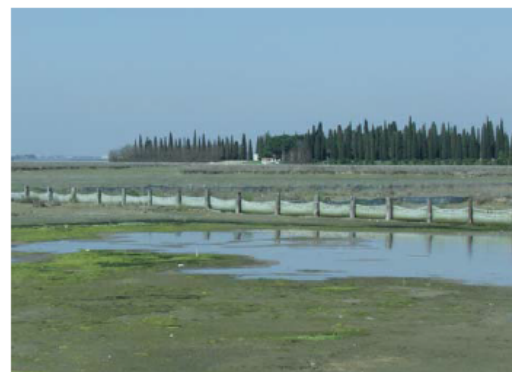
Conterminazione con parete filtrante in pali di legno distanziati per la realizzazione di strutture morfologiche artificiali.
