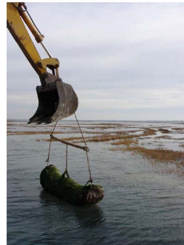
Figura 2-31 Operazione di rimozione delle burghe lungo il canale di Burano.
