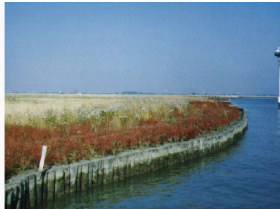
Protezione dei margini barenali naturali mediante conterminazione in pali di legno accostati.
