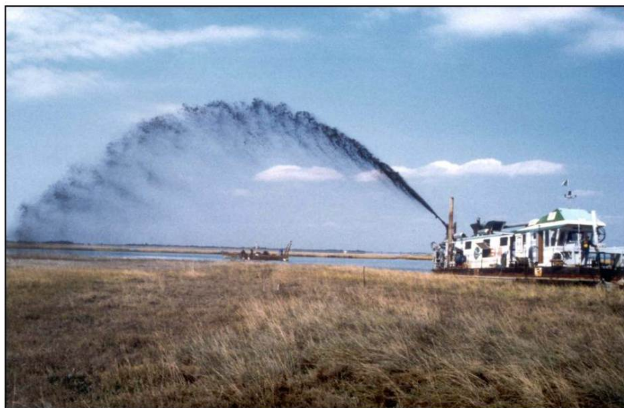
Figura 2-35 Ripascimento a strato sottile.
