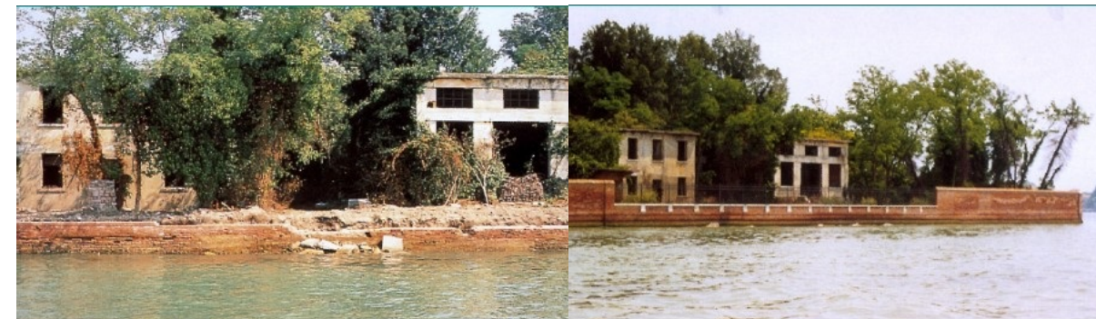
Figura 2-21 Consorzio Venezia Nuova, isola della Certosa: la riva prima degli interventi (sn) e dopo gli interventi (ds).
