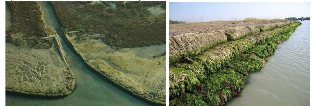
Figura 2-8 Fascinata di sedimentazione: canale Scanello a Burano (sn) e barena canale Dese (ds) (Fonte: Consorzio Venezia Nuova).
