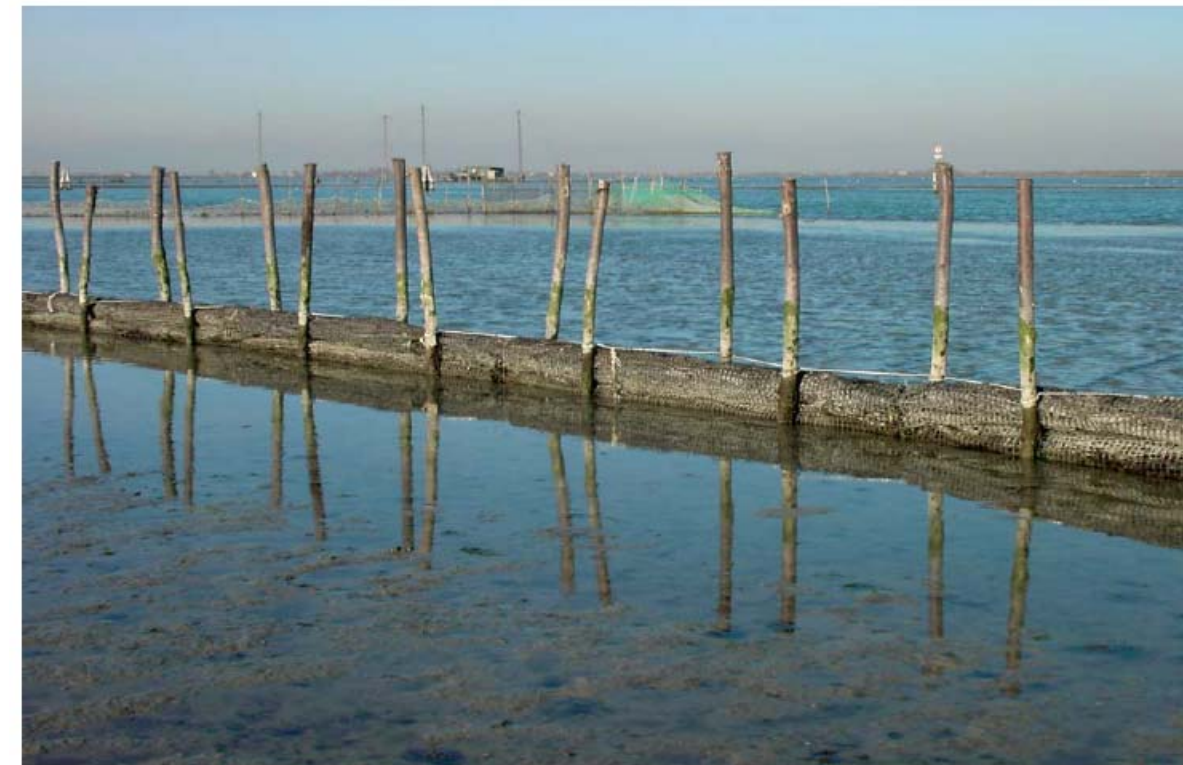
Figura 2-34 Fascinata di sedimentazione: canale Scanello a Burano (sopra) e barena canale Dese (sotto).
