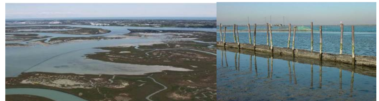
Figura 2-9 Canale di Burano. Protezione in burghe. Riempimenti a tergo e raccordo con il ghebo esistente (sn); la colonizzazione delle burghe da parte di organismi bentonici riguarda soprattutto la fascia di escursione di marea, mentre la fascia inferiore a diretto contatto con il piano sedimentario è colonizzata da una comunità semplificata (ds) (Fonte: Consorzio Venezia Nuova).
