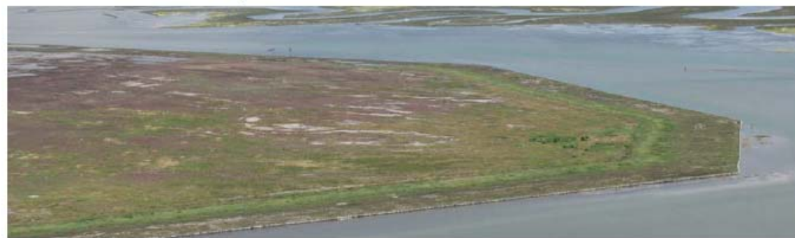
Figura 2-33 Barena Lago Teneri, realizzata con sedimenti tipo B. Dopo circa 5 anni sia il corpo centrale che la coronella risultano ben vegetati.
