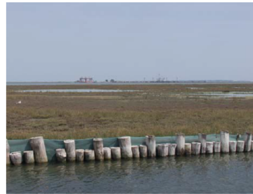
Conterminazione con parete filtrante in pali di legno accostati per la realizzazione di strutture morfologiche artificiali.
