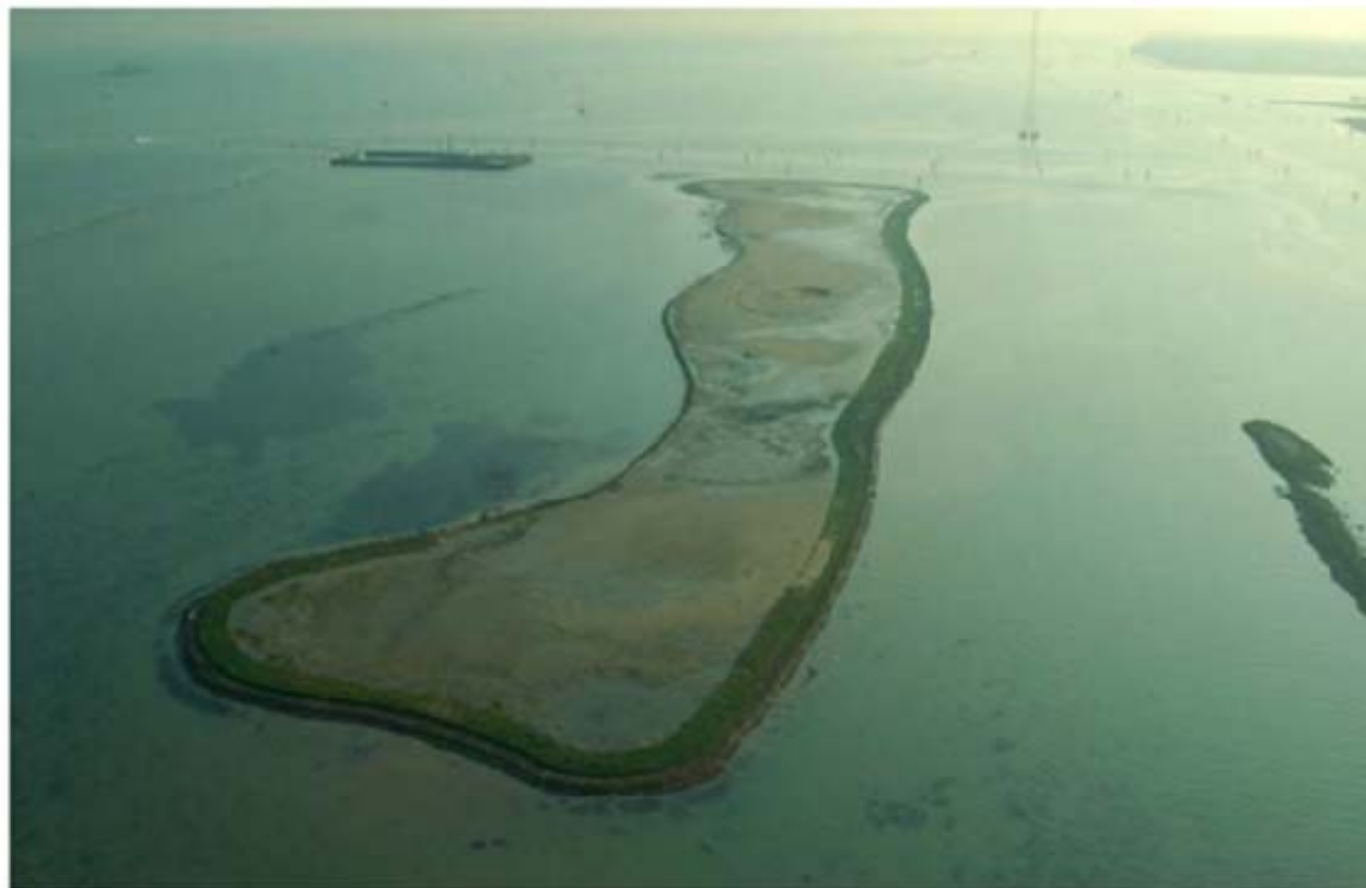
Figura 2-5 Barena canale Fusina, realizzata nel 2006 lungo il canale Malamocco-Marghera. Questa struttura con funzione di canalizzazione e intercettazione è realizzata con una conterminazione di burghe e materassi disposti su più livelli per proteggere il margine dal moto ondoso da vento e dalle onde e correnti prodotte dalle navi (Fonte: Consorzio Venezia Nuova).
