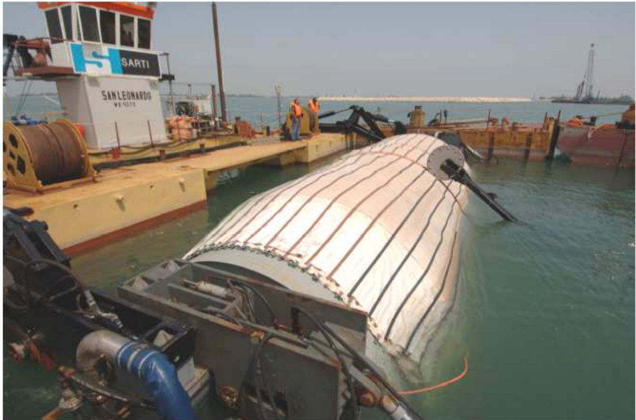
Figura 11. Bocca di Lido. S. Nicolò. Posizionamento materassino mediante pontone attrezzato.
