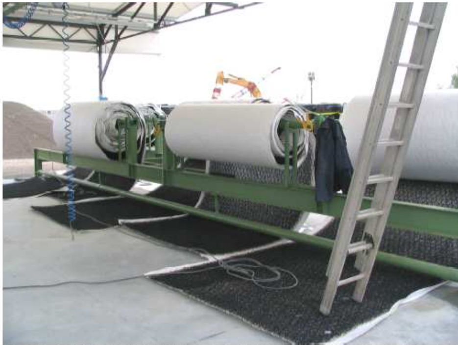
Figura 7. Bocca di Lido S. Nicolò. Rulli per la realizzazione del materassino filtrante zavorrato.
