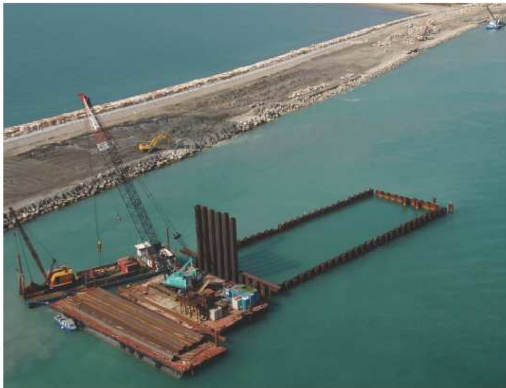
Figura 6. Bocca di Lido S. Nicolò. Spalla sud Rinforzo radice molo sud (Vista da lato mare). 01/09/2006
