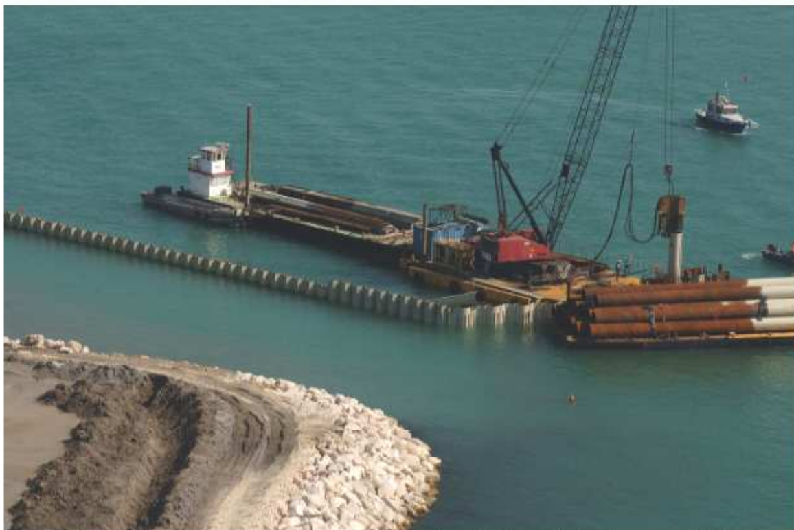
Figura 4. Bocca di Lido Treporti. Spalla ovest. Infissione palancole. Vista da isola - lato mare 01/09/2006.
