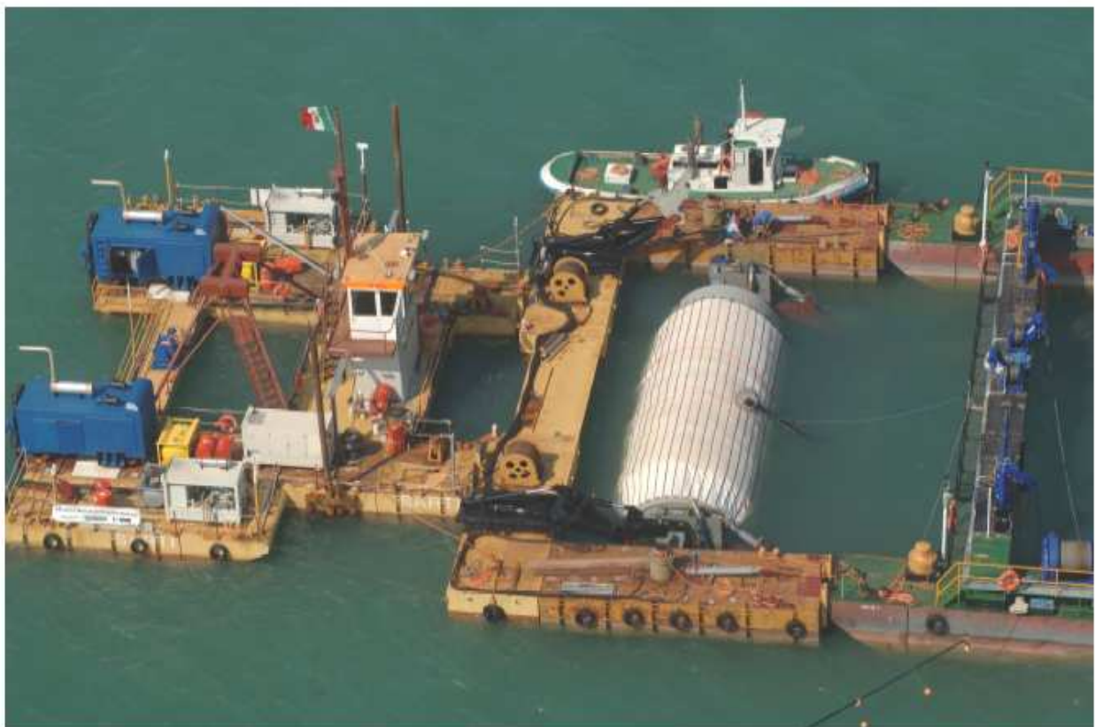
Figura 12. Bocca di Lido S: Nicolò. Posizionamento materassino mediante pontone attrezzato.
