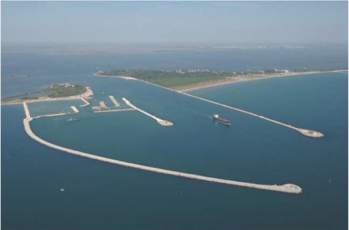
Figura 1. Bocca di Malamocco. Vista dei cantieri dal lato mare. 01/09/2006
