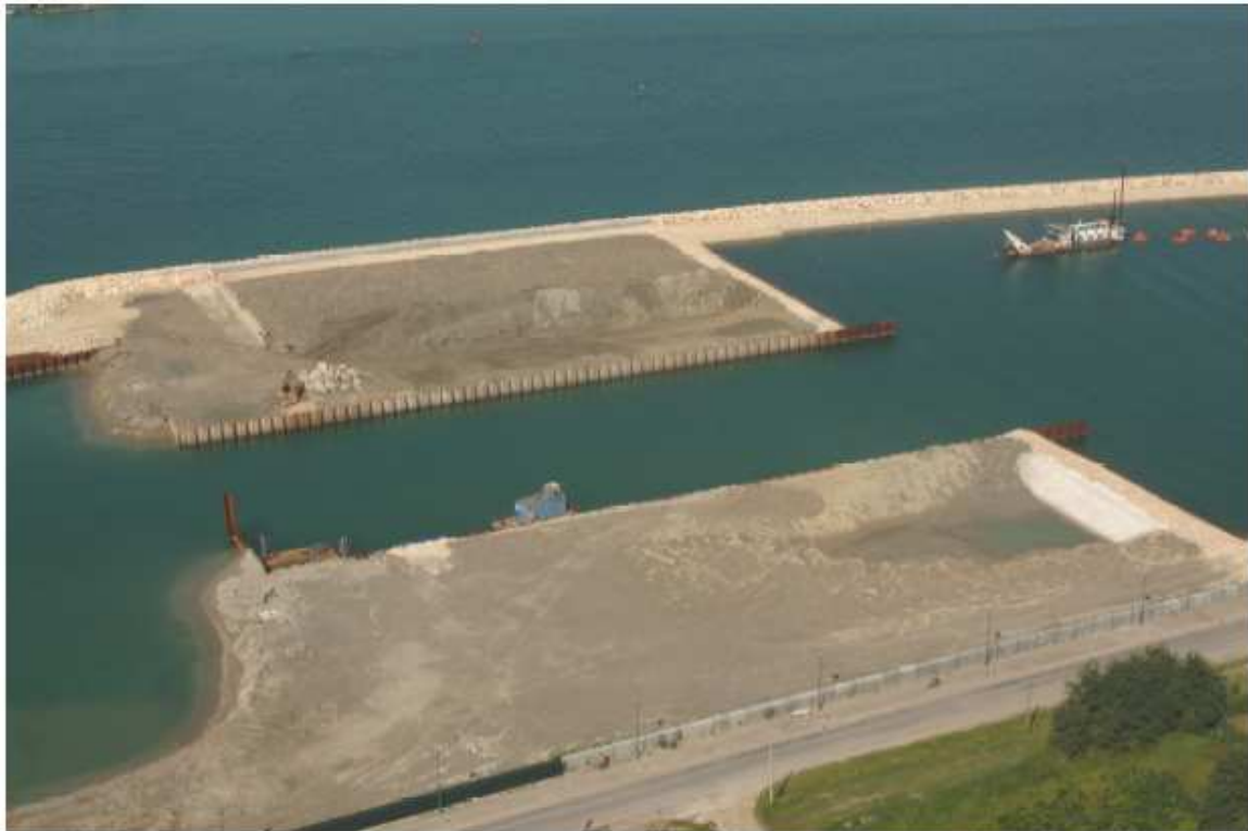
Figura 3. Bocca di Lido Treporti. Riempimento terrapieno conca di navigazione. Vista da lato Treporti. 01/09/2006
