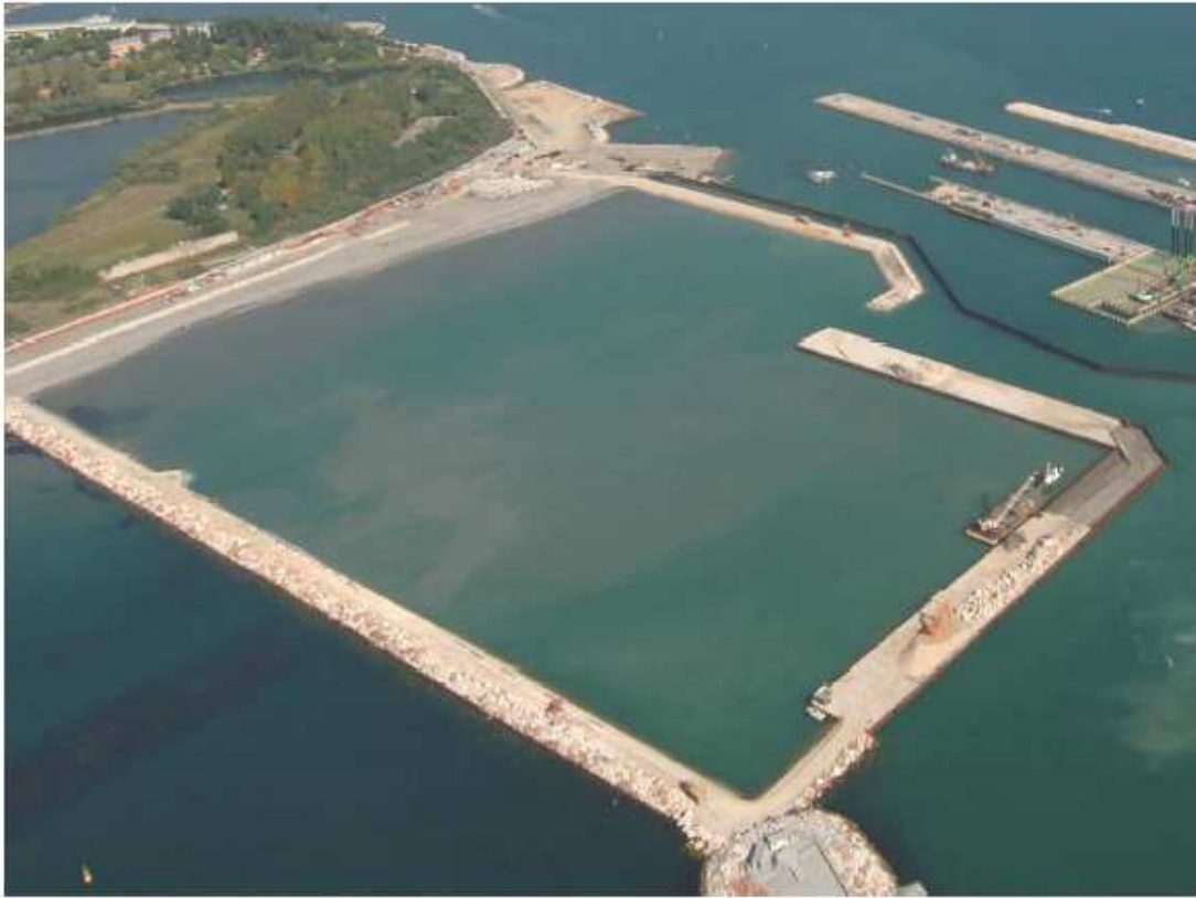
Figura10. Bocca di Malamocco. Infrastrutture per prefabbricazione cassoni. Completamento della conterminazione dell'area di refluento. 01/09/2006
