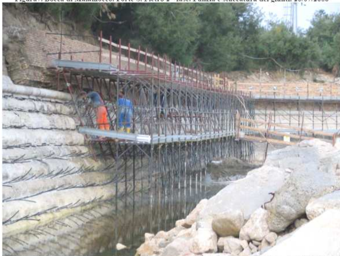
Figura 8. Bocca di Malamocco. Forte S. Pietro 2 a fase. Pulizia e stuccatura dei giunti. 24/08/2006
