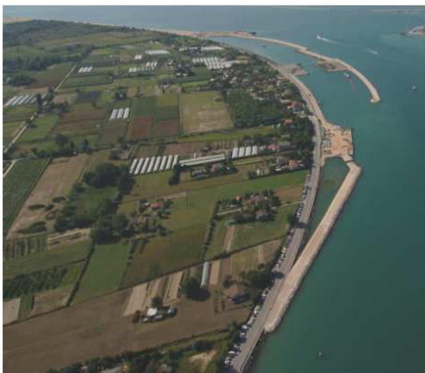
Figura 1. Bocca di Lido Treporti. Tura e porto rifugio (vista da lato laguna). 01/09/2006
