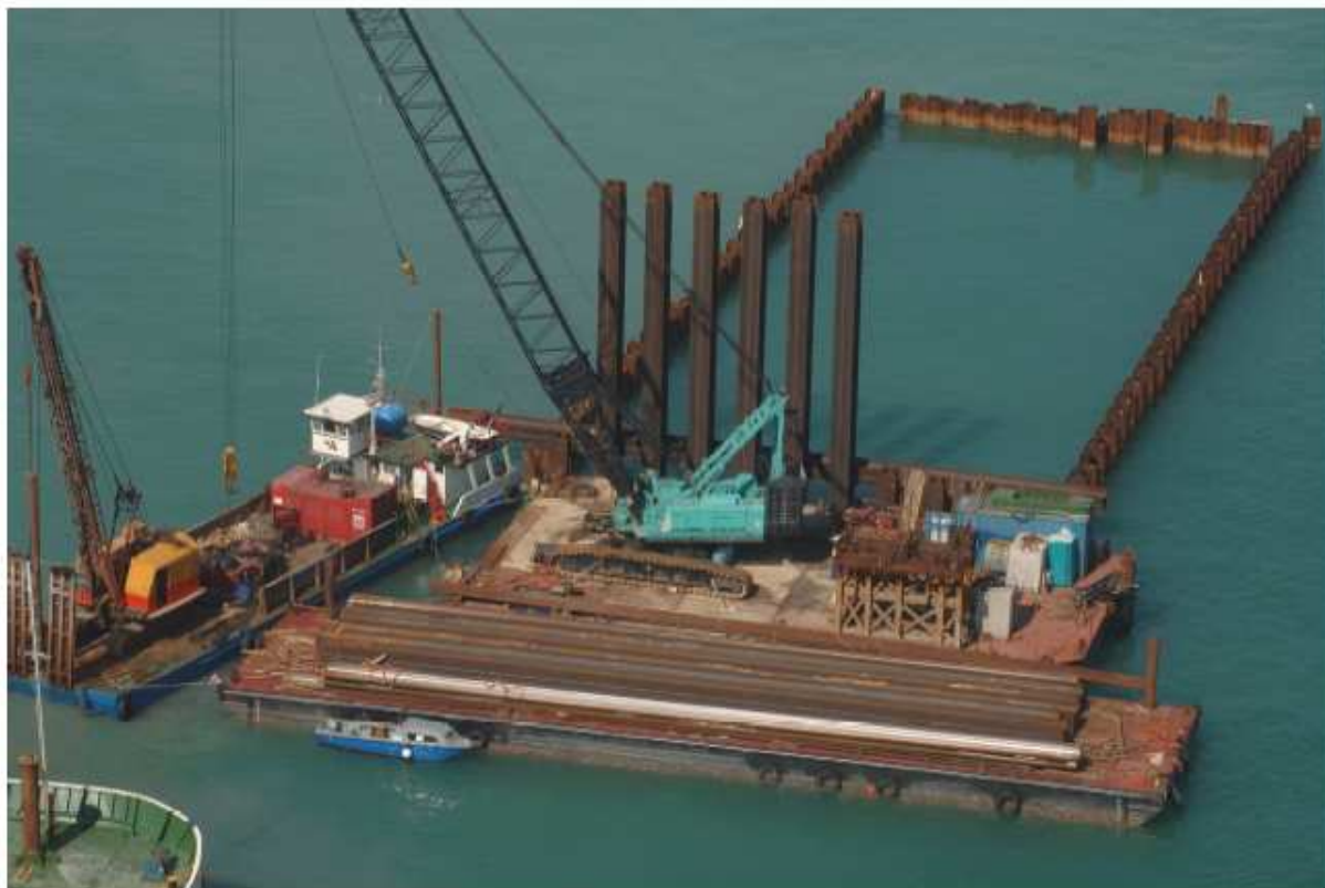
Figura 13. Bocca di Lido S. Nicolò. Spalla sud. Infissione palancole. 01/09/2006.
