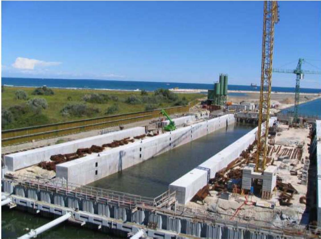
Figura 3. Bocca di Chioggia. Conche per pescherecci. Coronamento in calcestruzzo. 30/08/2006
