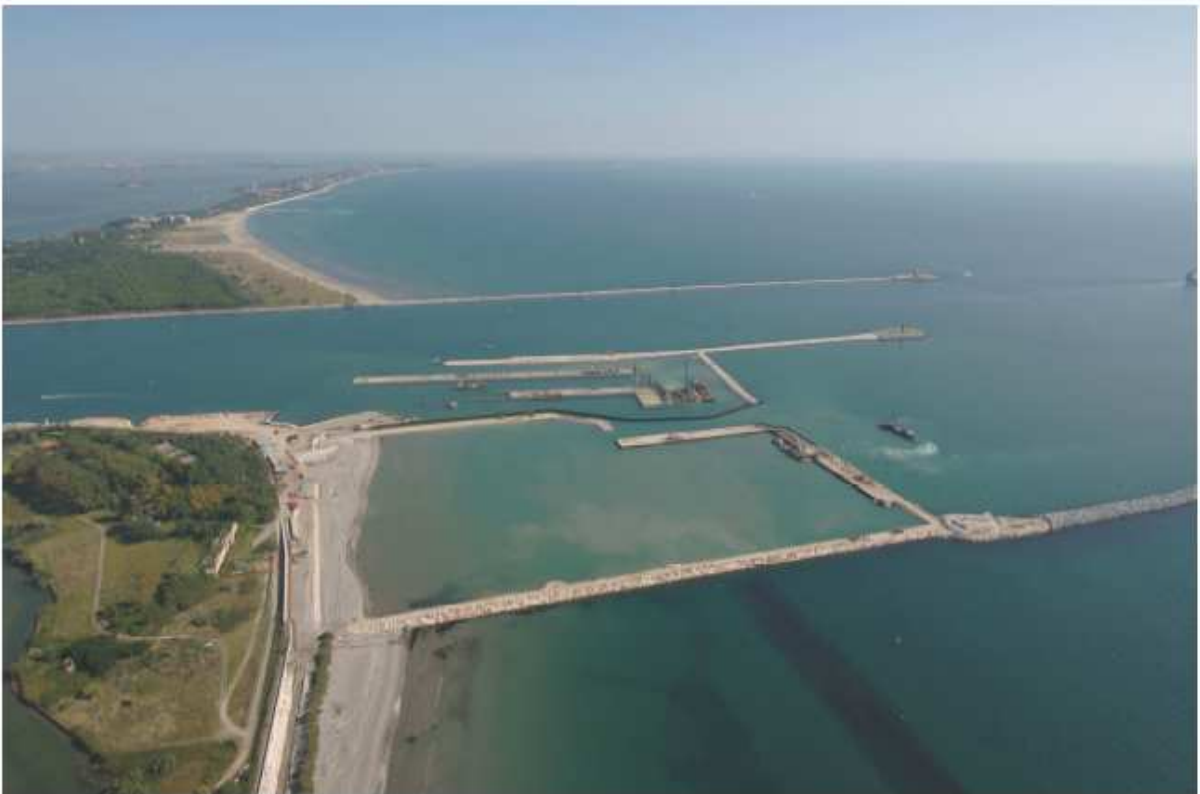
Figura 2. Bocca di Malamocco. Conca di navigazione e infrastrutture per prefabbricazione cassoni. 01/09/2006
