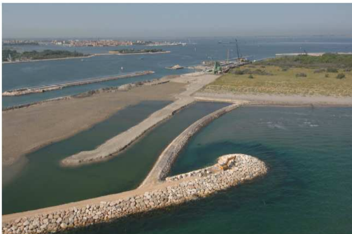
Figura 10. Bocca di Chioggia. Tura (1^ fase). Realizzazione mantellata scogliera lato mare. 01/09/2006
