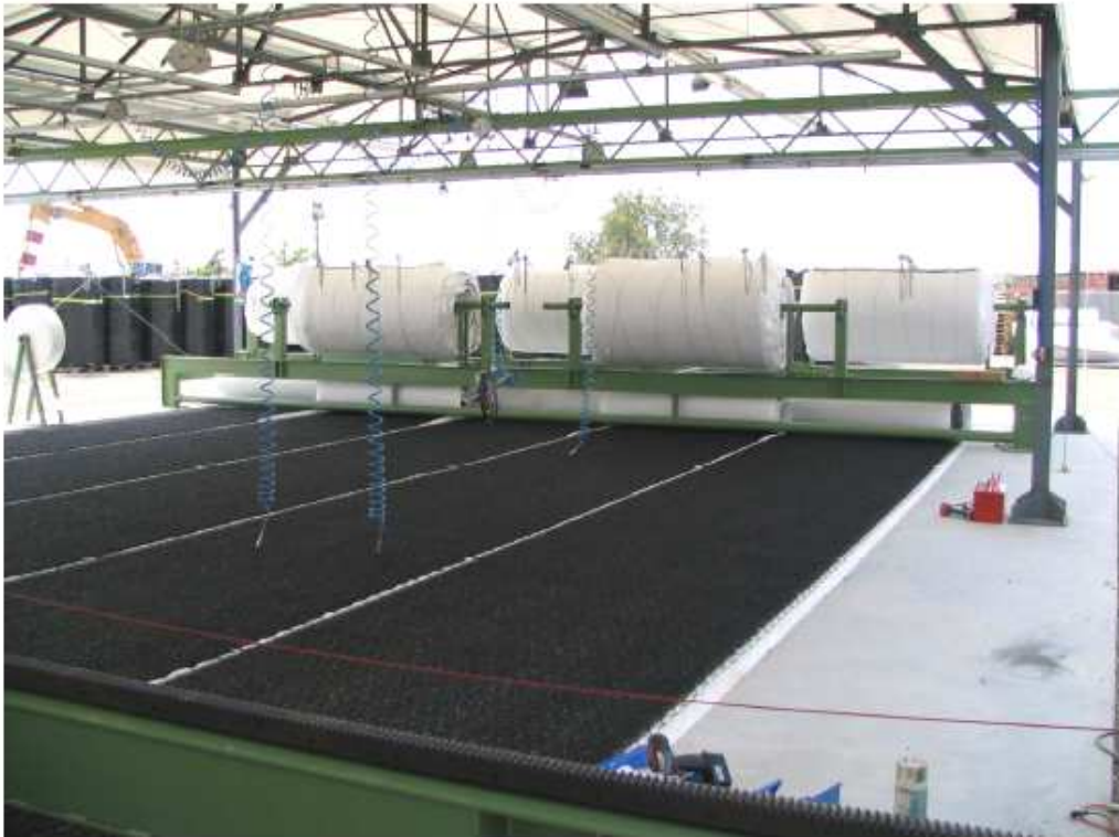
Figura 9. Bocca di Lido S. Nicolò. Realizzazione materassini filtranti zavorrati.
