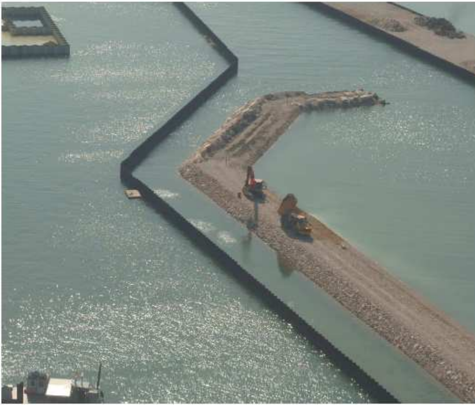
Figura 11. Bocca di Malamocco. Infrastrutture per prefabbricazione cassoni. Completamento della conterminazione dell'area di refluento. 01/09/2006
