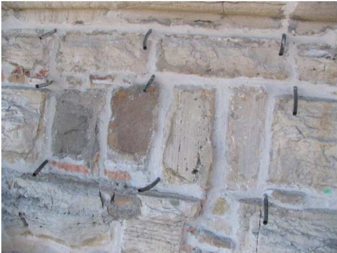
Figura 7. Bocca di Malamocco. Forte S. Pietro 2 a fase. Pulizia e stuccatura dei giunti. 20/07/2006
