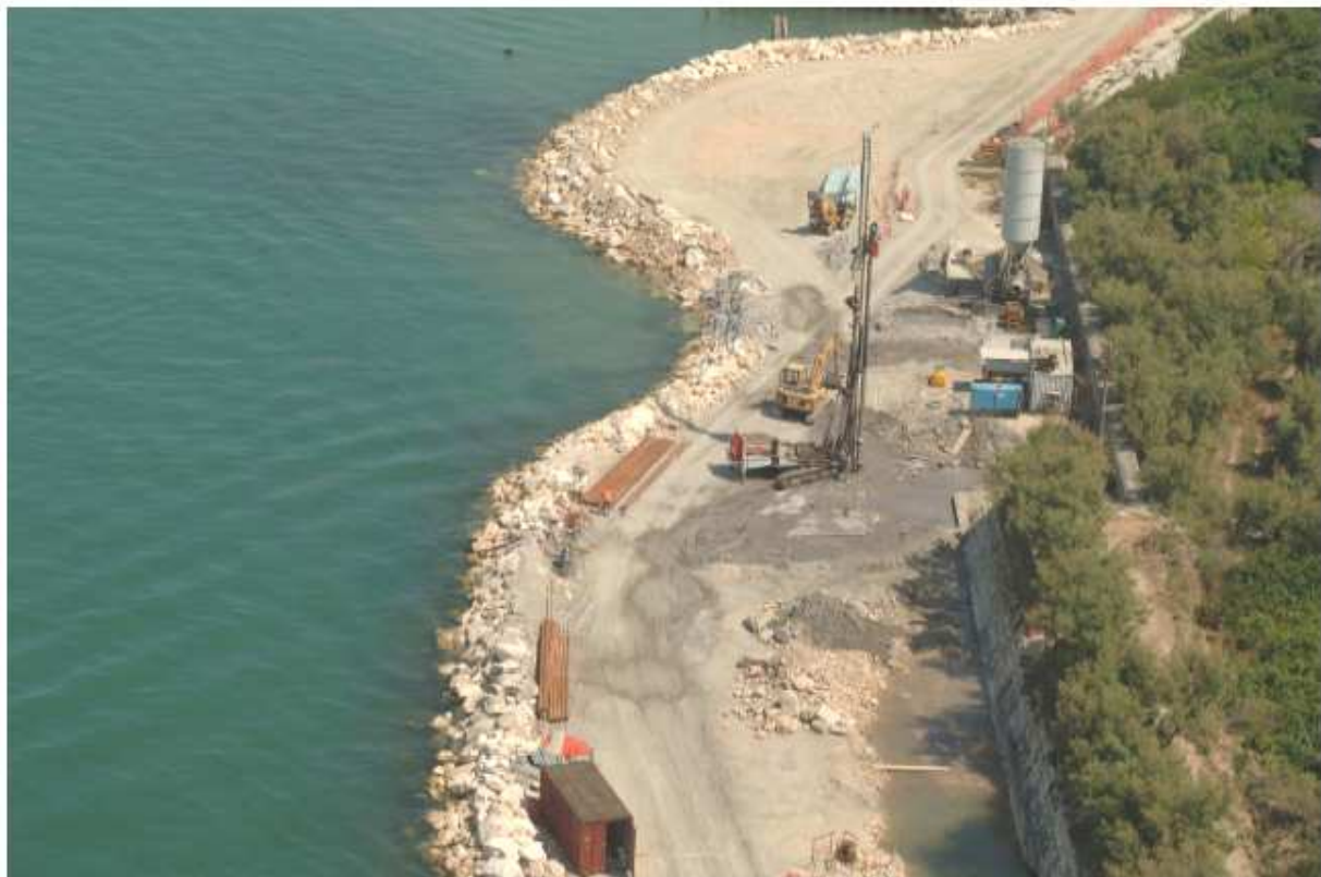
Figura 6. Bocca di Malamocco. Conca di navigazione – Protezione sponda. Realizzazione micropali, 14/07/2006
