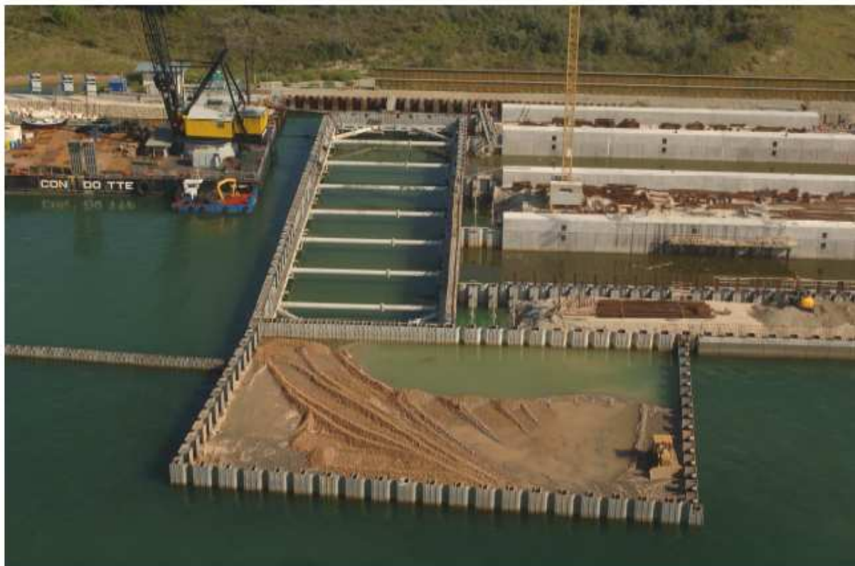
Figura 9. Bocca di Chioggia. Spalla nord. Riempimento dei terrapieni d'ala con materiale granulare. 01/09/2006
