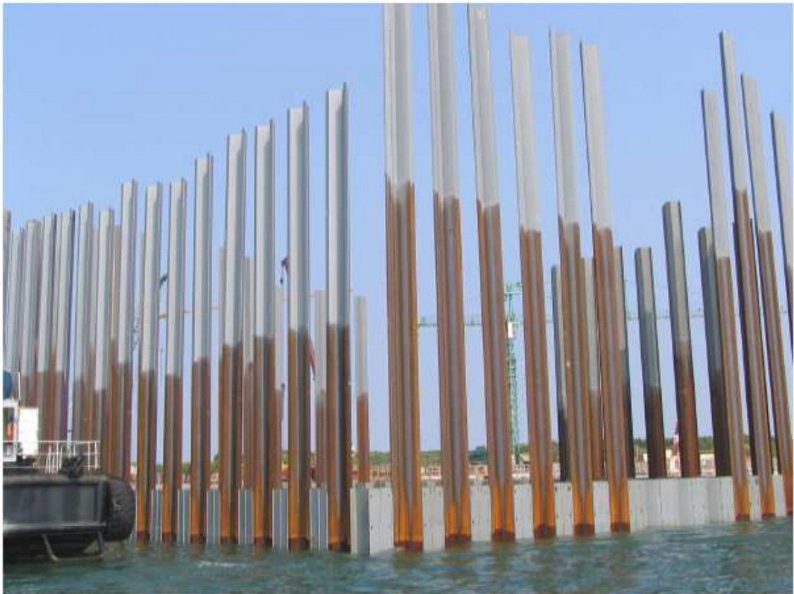
Figura 7. Bocca di Chioggia. Spalla nord. Infissione palancole. 28/07/2006
